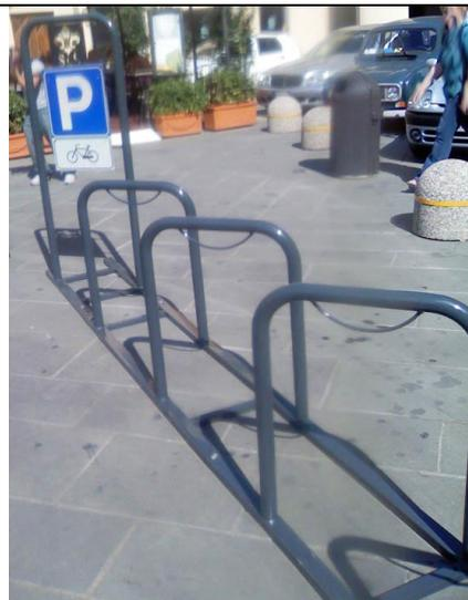
Il sistema ad U rovesciata in dotazione a Firenze. Molto pratico ed economico, permette l'installazione di archetti ad U rovesciata in perpendicolare ad un marciapiede ma anche ad angolo per ovviare a limitazioni di spazio
